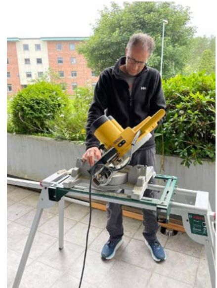
Hjelper til med det som er mulig, her er det saging i forbindelse med legging av gulv. Juli-22.
